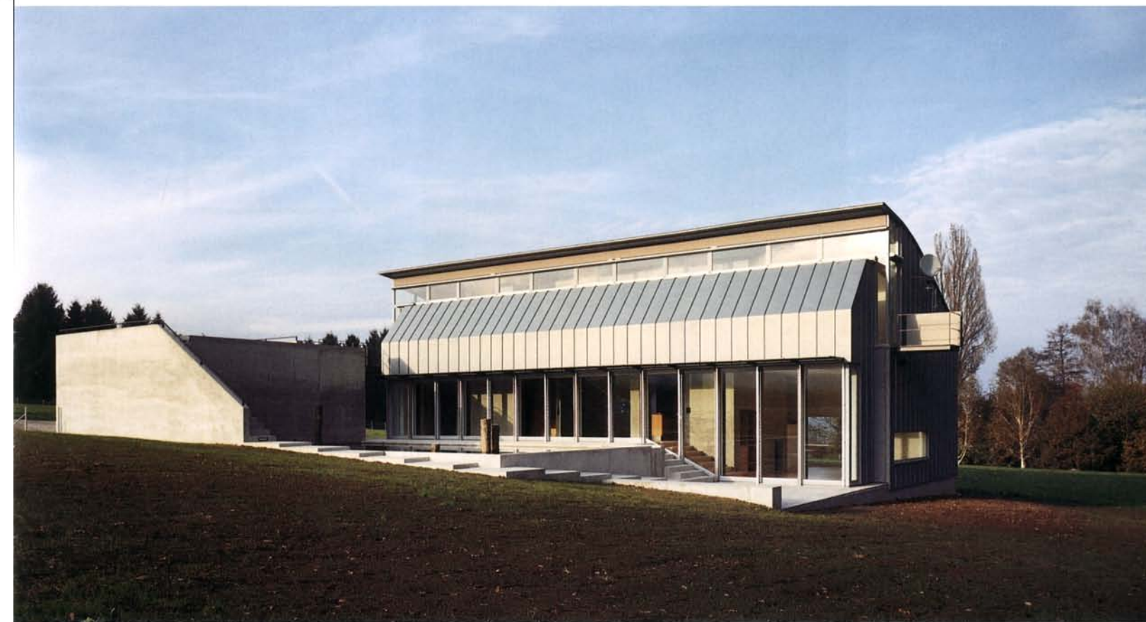
Das Haus und die präzise Außengestaltung bilden eine wohl kalkulierte planerische Einheit.
